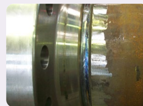
Rohr-Flansch-Verbindung geschweißt mit manueller UP-Technik
