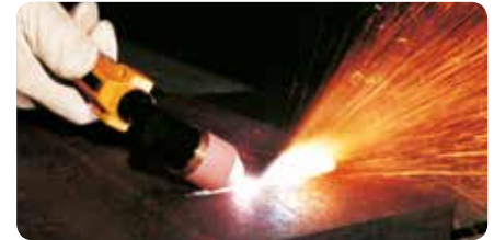
Plasmafugen zur Vorbereitung von Schweißnähten Plasma gouging for weld preparation purposes
